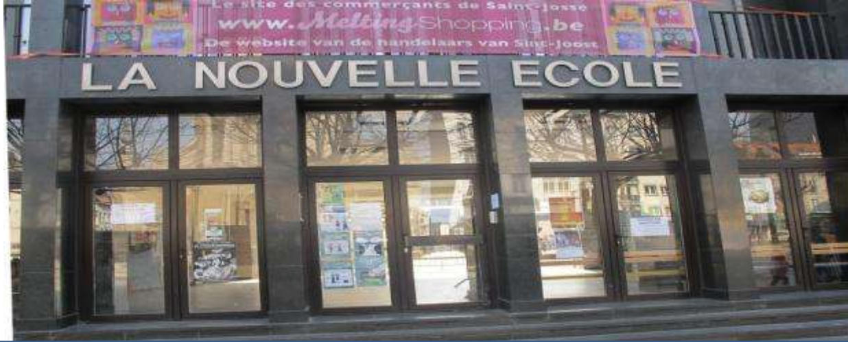
Plusieurs portes vitrées « réfléchissantes » Peu engageant pour une école! On dirait des bureaux
